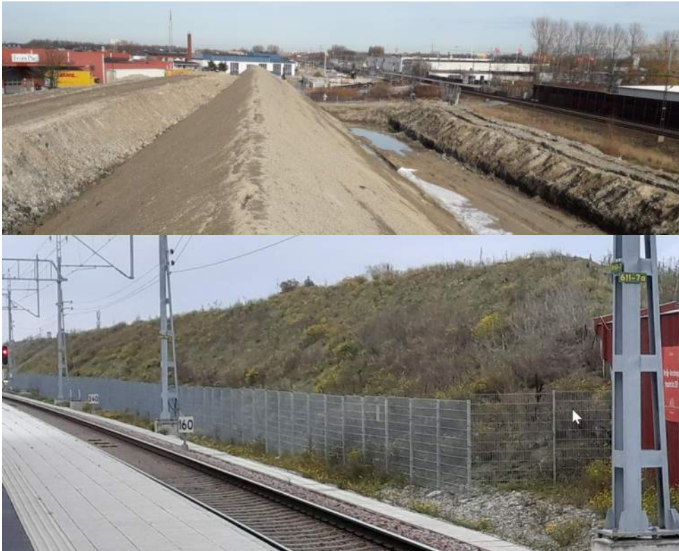
Figur 10: Överst nyanlagd bullerskyddsfall fotograferad mot Lund i början av 2019. Nederst bullerskyddsfall fotograferad från Burlövs station mot Malmö 22 oktober 2022. Foto Ragnhild Karlsson
