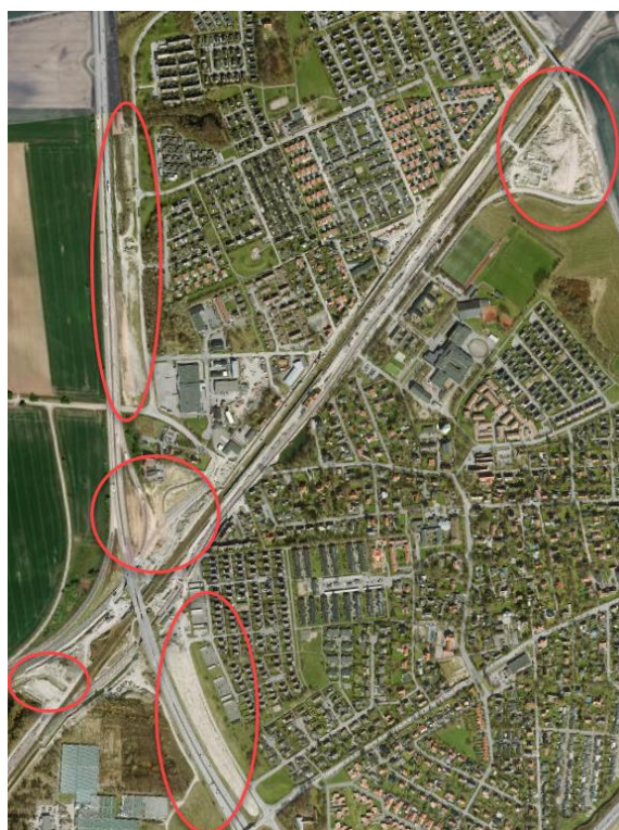
Figur 1: Flygbild över Åkarp där områden som används för hantering av schaktmassor från fyrspårsutbyggnaden mellan Lund och Malmö är inringade. Inringade områden utgör både tillfälliga lagringsställen som ska avvecklas och nyanlagda, permanenta bullerskyddsvallar. Projektet har utöver i Åkarp flera tillfälliga lagringsplatser i Hjärup och Lund. Källa: Eniro karttjänst flygfoto.
