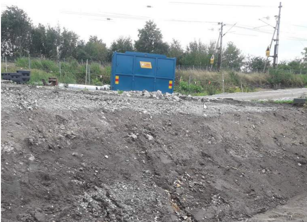
Figur 1 Parkslidebeståndet bakom containern är markerat med flaggband. Foto taget 2020-09-04 innan nergrävningen påbörjades. Foto Ragnhild Karlsson
