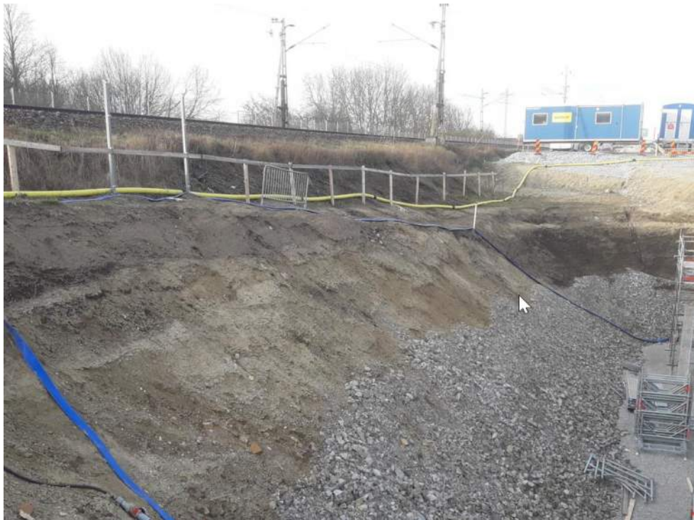
Figur 2 Slänt där skyddsavståndet 7 m från parksliden inte kunnat upprätthållas p g a närheten till järnvägen. Foto tager 2021-04-15. Jorden grävdes bort i samband med tunnellsanseringen när järnvägen grävdes i augusti 2021. Foto Ragnhild Karlsson.
